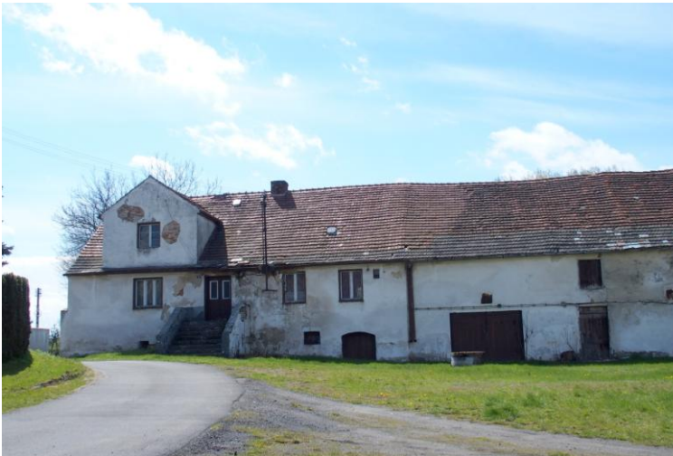
Bud. mieszkalno- gosp. nr 9-10, od północnego-zachodu
