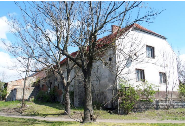
Bud. mieszkalno- gosp. nr 3, widok od zachodu
