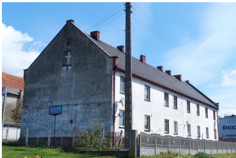
Bud. mieszkalno- gosp. nr 11, widok od zachodu
