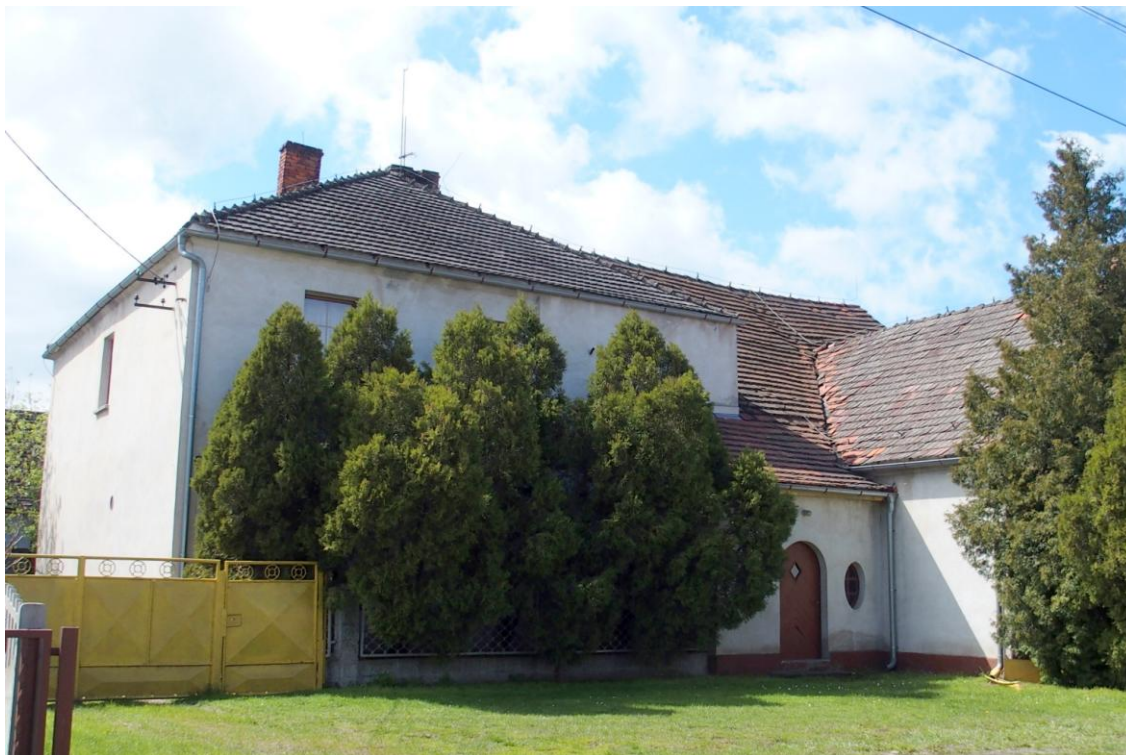
Widok budynku od północnego-wschodu
