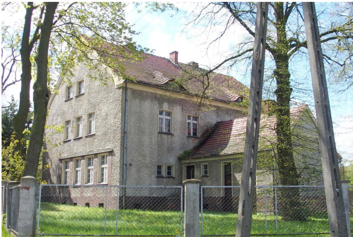
Widok budynku od wschodu
