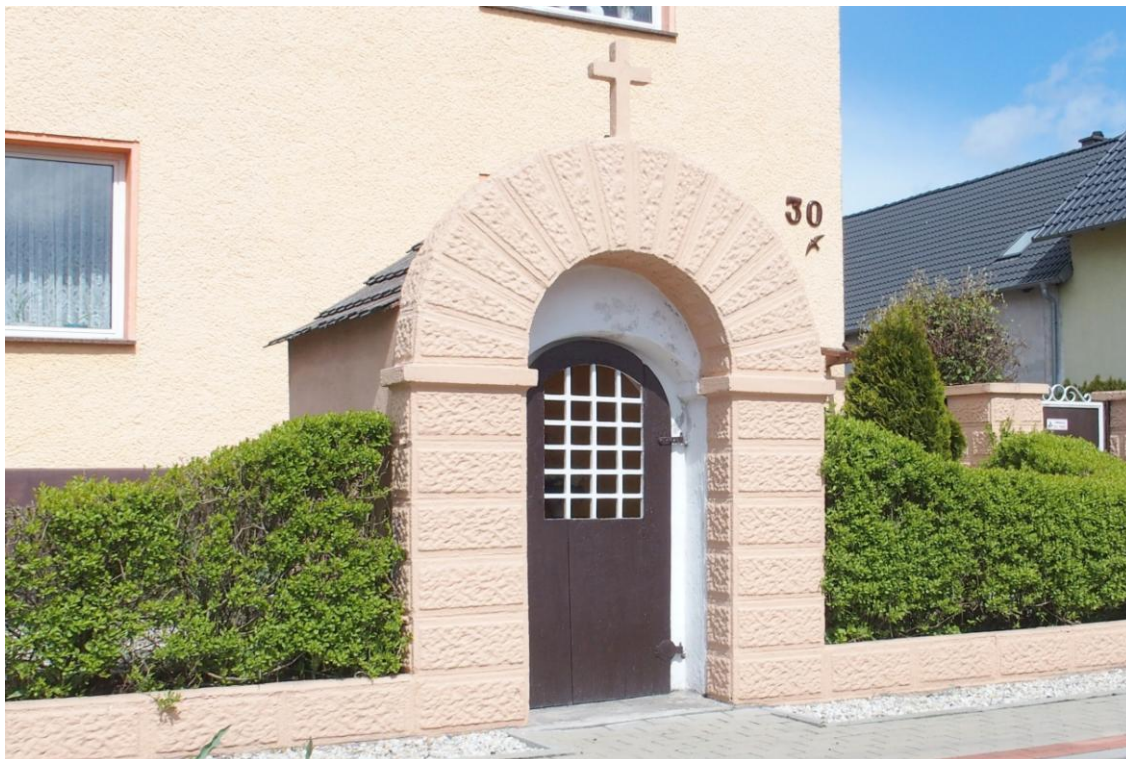
Widok od południowego-zachodu
