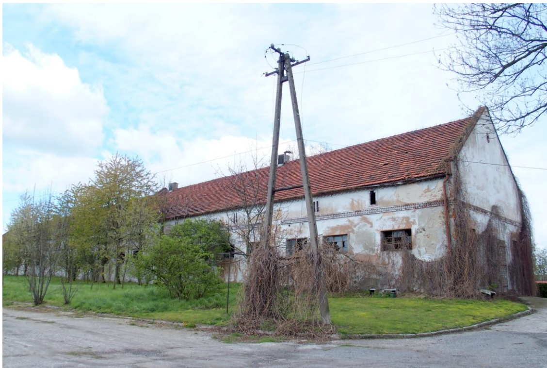
Widok budynku od wschodu
