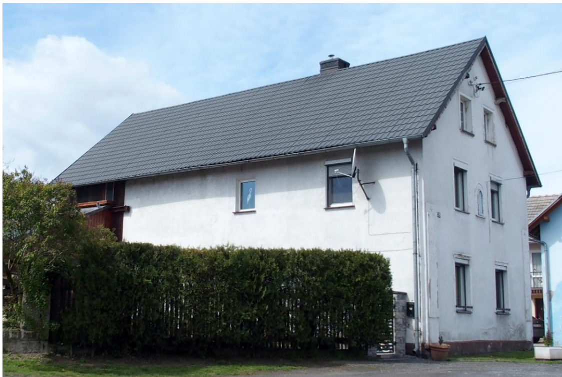
Widok budynku od wschodu
